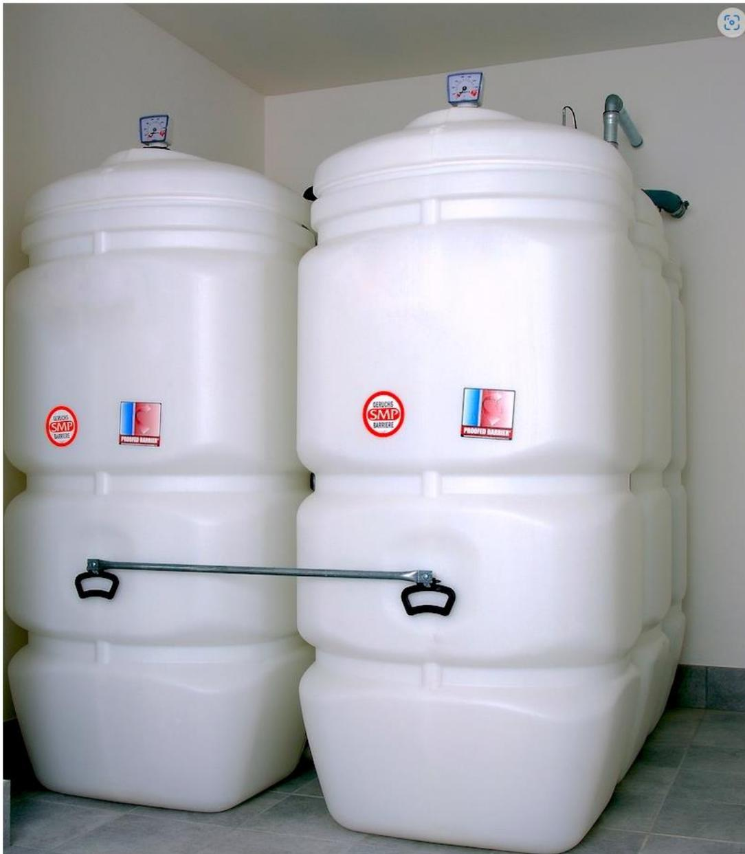
Zum Bild: Moderne, doppelwandige Kunststoff-Tanks sind absolut alterungs- und korrosionsbeständig. Damit sind private Öltankbesitzer immer auf der „sicheren Seite“. Zudem braucht man aufgrund der höheren Brennstoffqualität weniger Vorratsmenge, wodurch im Heizungskeller wiederum [zusätzliche Stellfläche](#) gewonnen wird.
