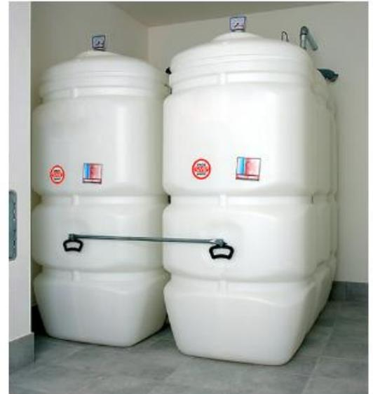
Moderne, doppelwandige Kunststoff-Tanks sind absolut alterungs- und korrosionsbeständig. Damit sind private Öltankbesitzer immer auf der „sicheren Seite“. Zudem braucht man aufgrund der höheren Brennstoffqualität weniger Vorratsmenge, wodurch im Heizungskeller wiederum zusätzliche Stellfläche gewonnen wird. Foto: Bundesverband Lagerbehälter e.V.
